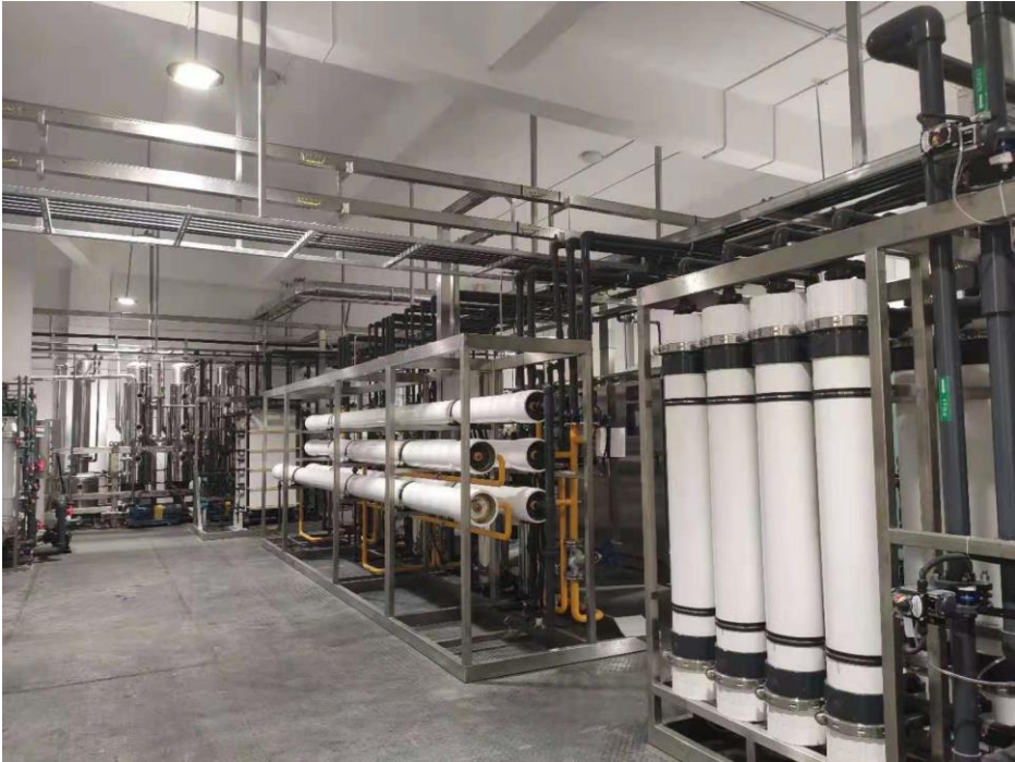
图 4-21 废水末端深度处理
