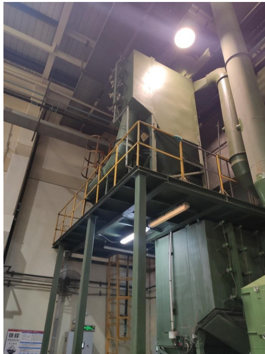
图 4-10 沉流式滤筒除尘器+高效过滤器
