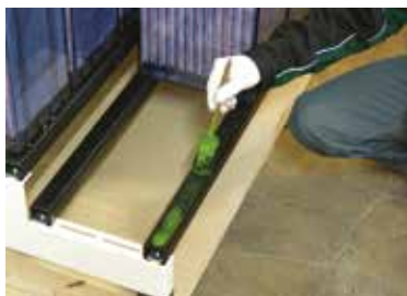
Obr. 5-13: Ošetrovanie úložných koľajníc
