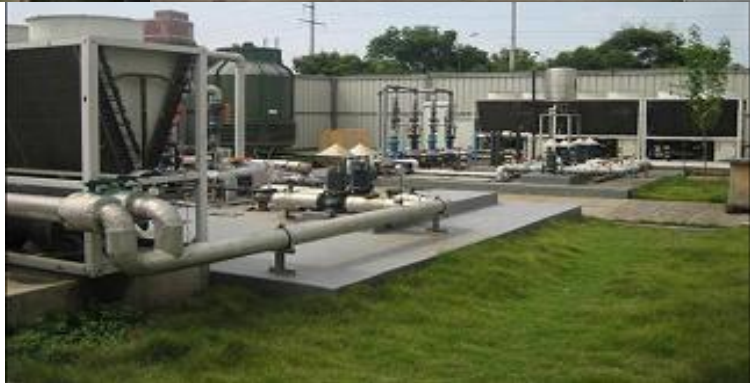
设施先进的冷却水装置：公司的工业冷却水循环利用率 90%以上
