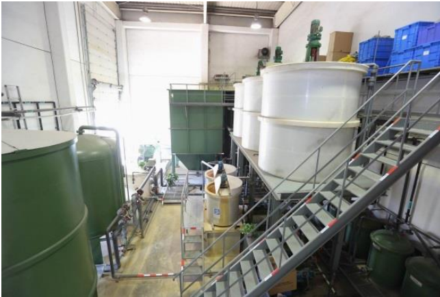
含铅废水的处理装置：能力 720 吨/天，保证了公司生产污水有效正常处理、达标排放
