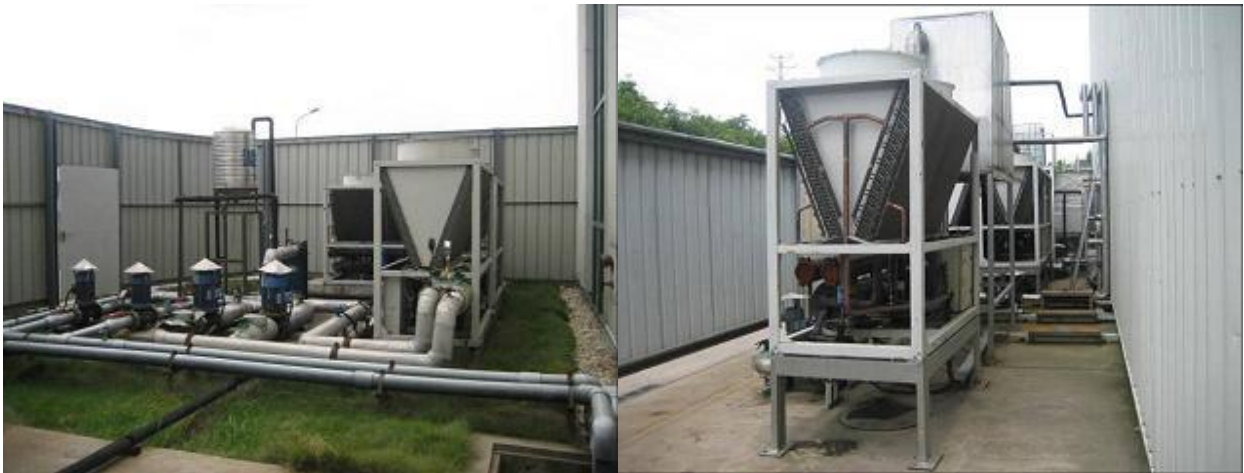
含铅废水的处理装置：能力 720 吨/天，保证了公司生产污水有效正常处理、达标排放
