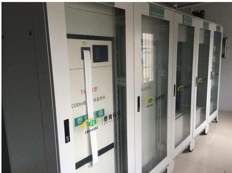
污水在线监测装置：总铅、COD、pH 值、流量，实时监控，数据 GPS 上传，与省、市、区环保部门联网，实时监控
