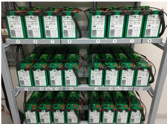
Abbildung 6.6.5-1 - Einsatz von Reihen- und Stufenverbindern
