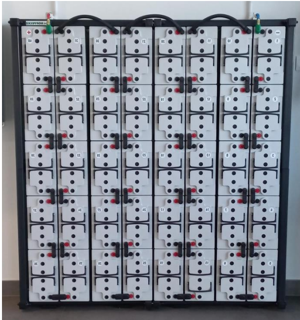
6-3 - Beispiel für horizontale Batterieanordnung
