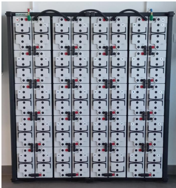
6-3 - Exemple de disposition horizontale des batteries
