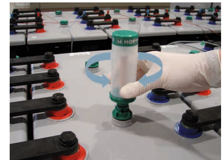
Abbildung 2: Einsetzen des AquaGen II
