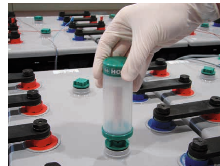
Abbildung 1: Einsetzen des AquaGen I
