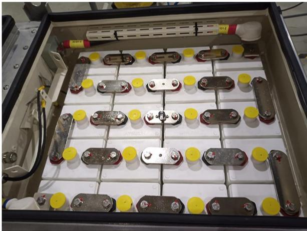
2. Montieren Sie die Zellverbinder gemäß der technischen Zeichnung. Verwenden Sie neue Federscheiben. Montieren Sie zuerst die Verbinder in den Zellenreihen, dann die Verbinder zwischen den Zellenreihen in umgekehrter Reihenfolge zur Deinstallation, siehe folgende Beispielabbildungen:
