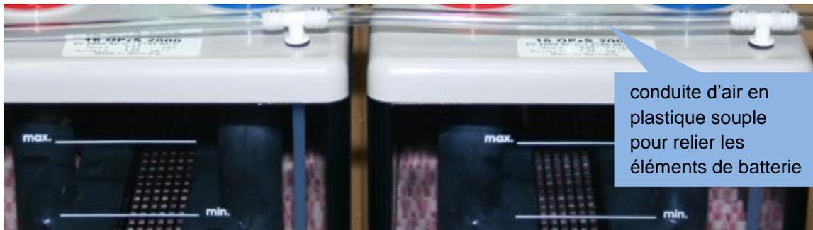
Fig. 10 : Branchement des conduites d'air - I
