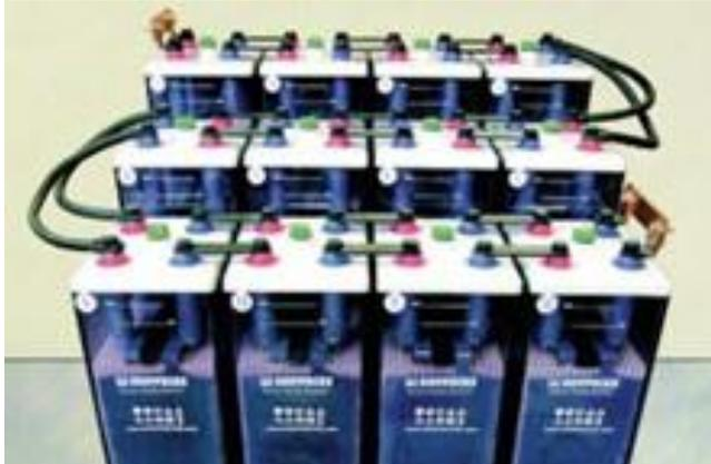
Abbildung 6.6.6-1 - Einsatz von Reihen- und Stufenverbindern
