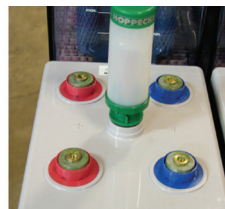
Fig. 5-14: bouchon-labyrinthe (à gauche) et système de recombinaison grid | AquaGen (à droite)
