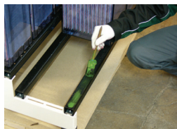
5-12 : Enduction des rails d'installation
